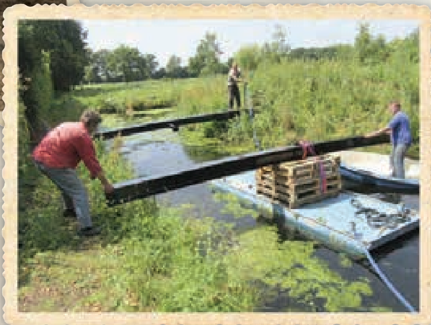
Beelden van de aanleg van het landgoed en de bouw van de schaapskooi
